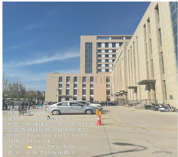
项目区现状（门诊部）
