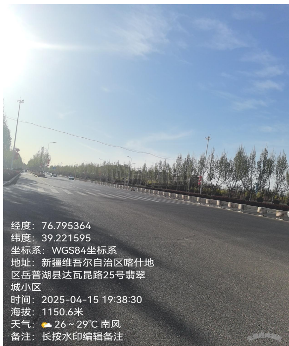
项目区北侧（市政大道）
