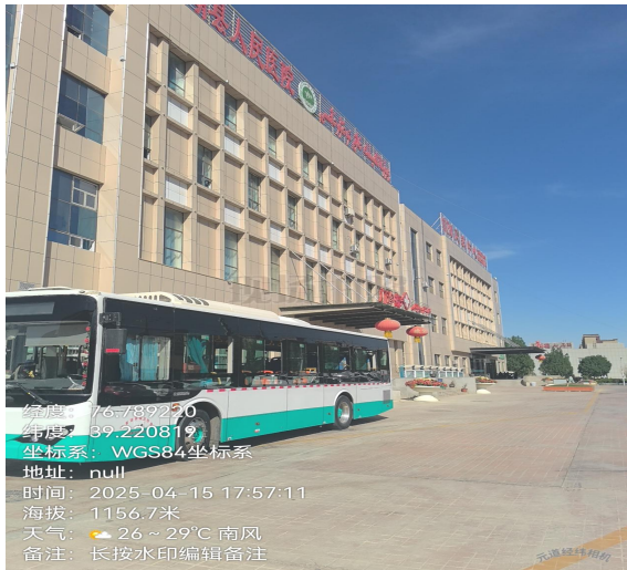
项目区现状（门诊部）
