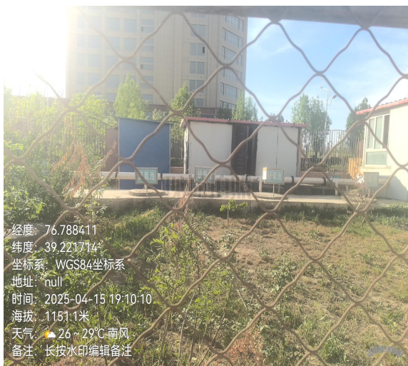
项目区现状（污水处理站）
