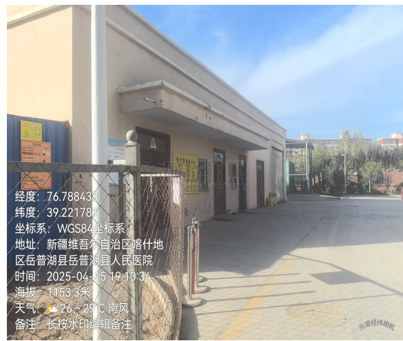
项目区现状（危废暂存间）
