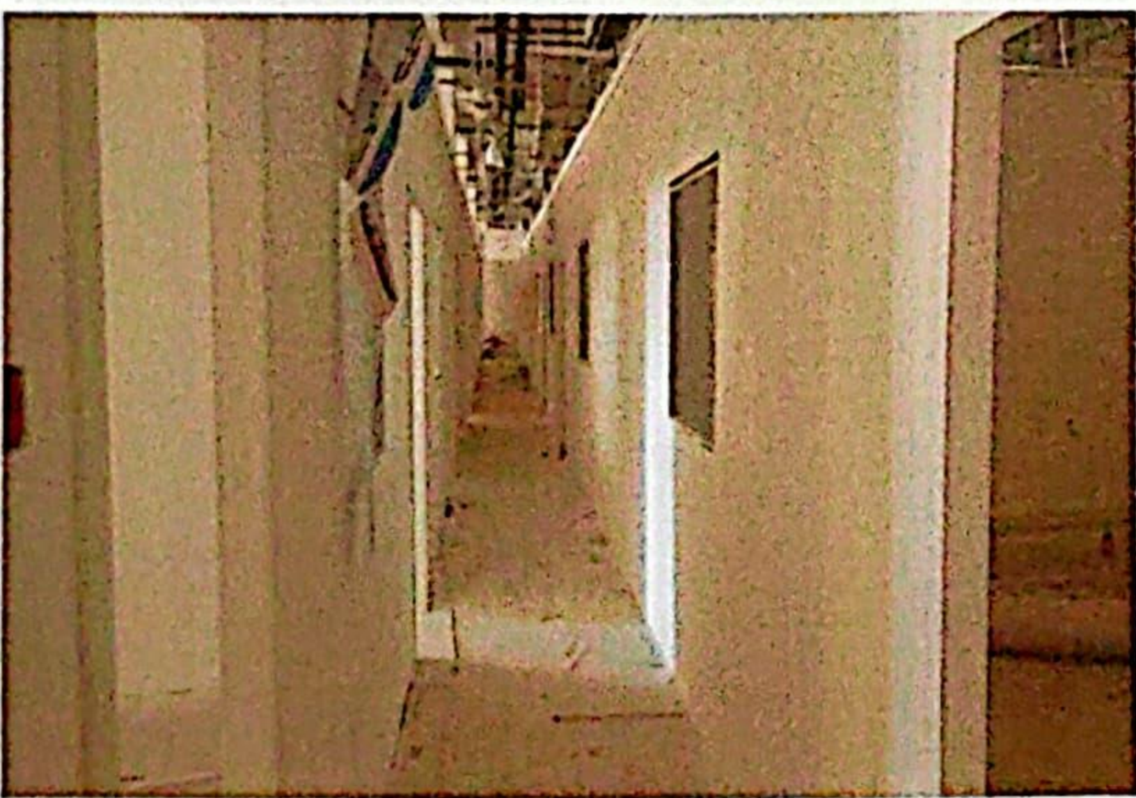
项目区室内现状
