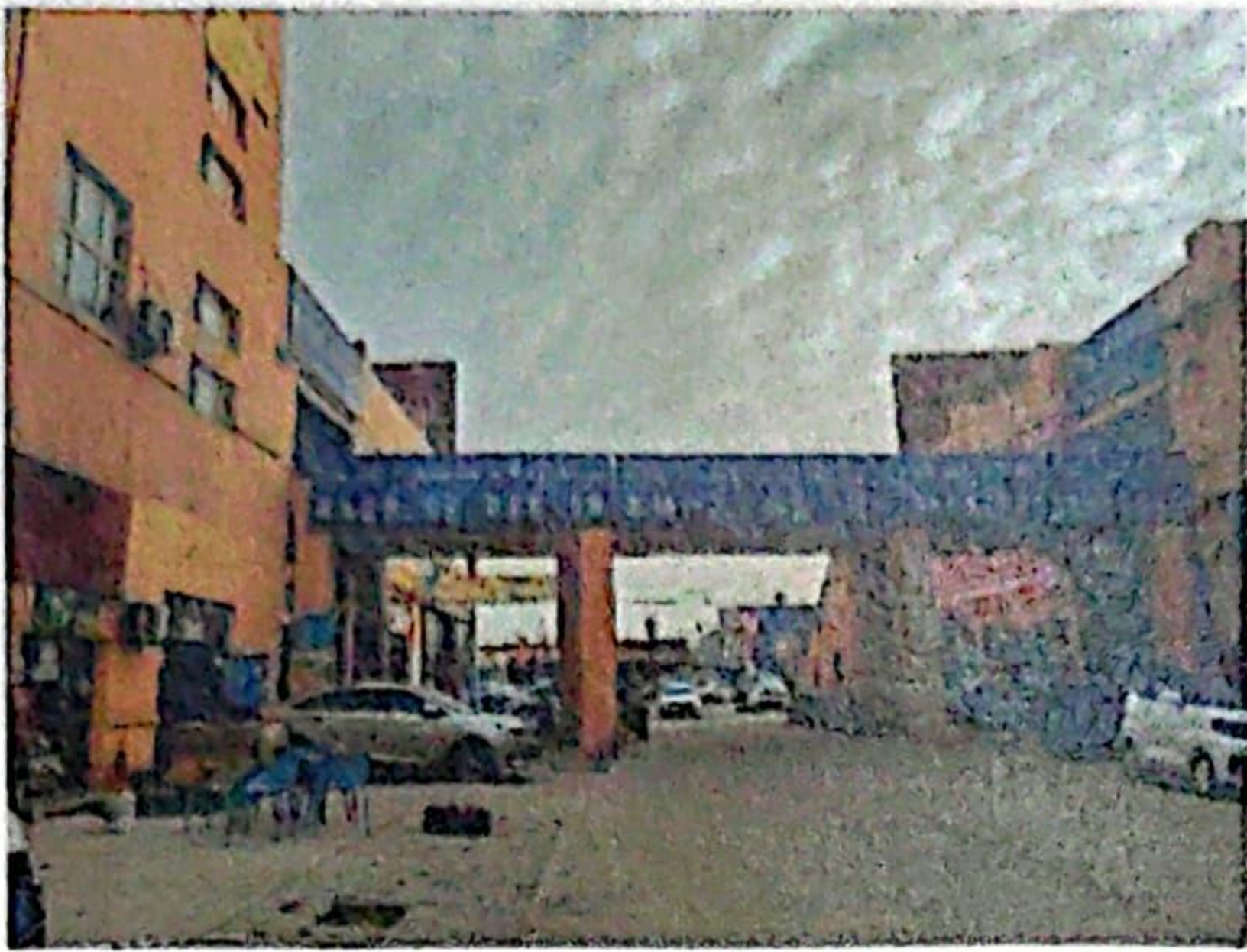
项目区东侧停车场
