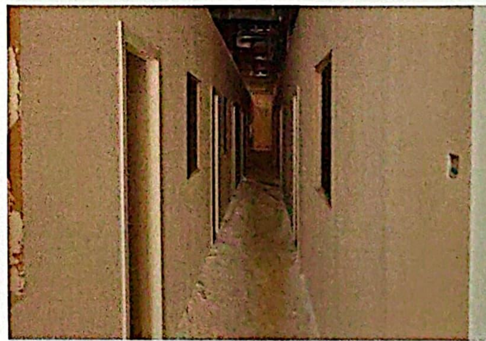
项目室内现状
