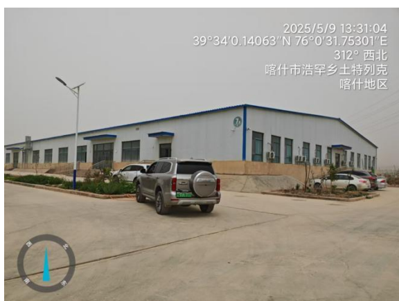
北侧 7 号办公区
