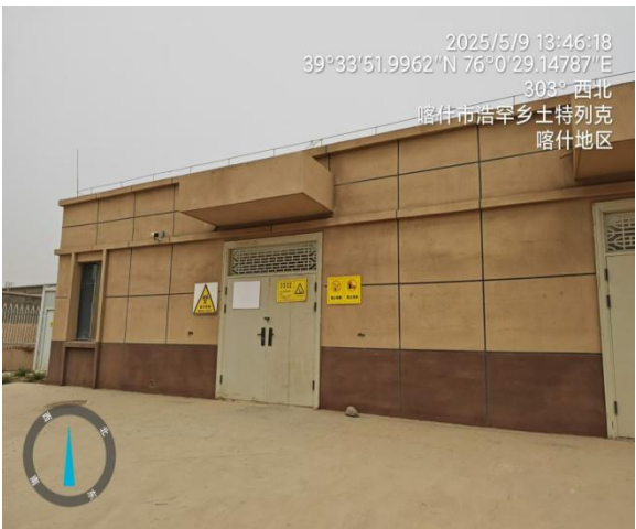
医院医疗废物暂存间
