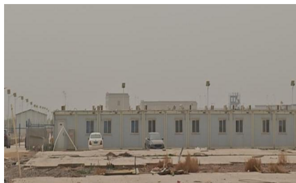
西侧紧邻废弃方舱医院
