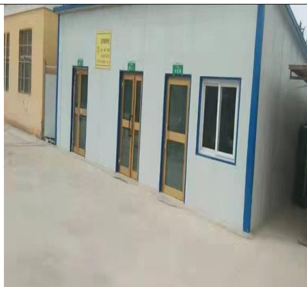
现有医疗废物暂存间（150m 3 ）
