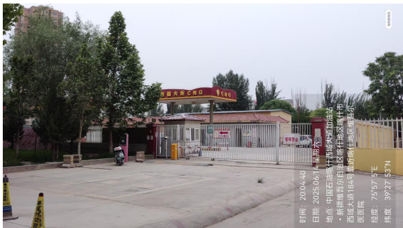
项目区西侧（加气站已停用）
