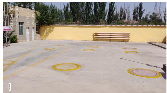
项目区现状（油罐区）
