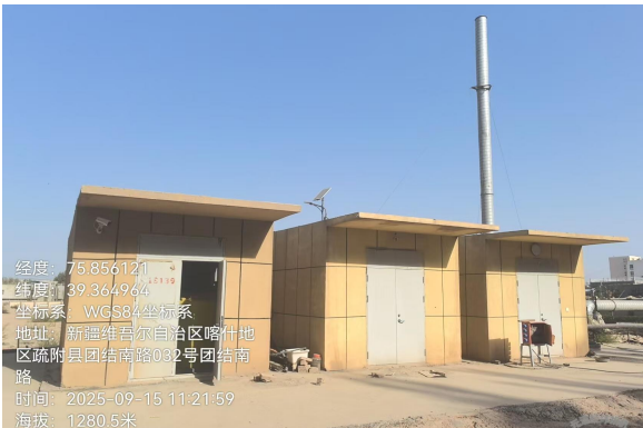
现状污水处理站（本项目依托）
