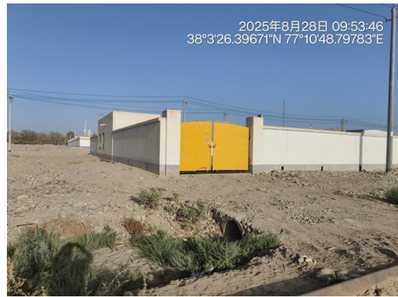
十乡调压站现状
