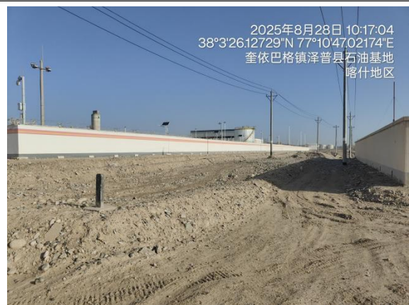
泽普加压站与十乡调压站中间空地
