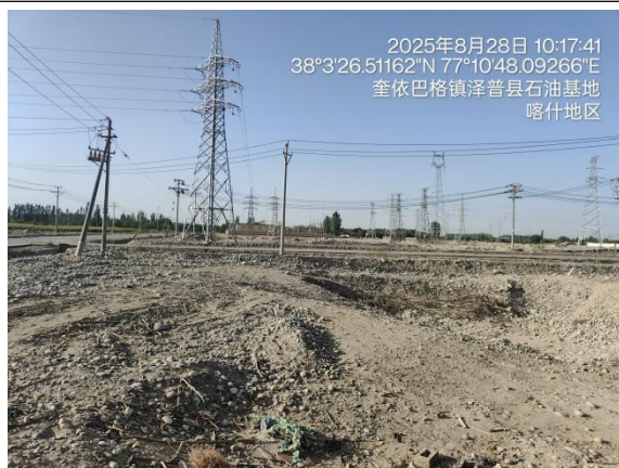
十乡调压站南侧空地
